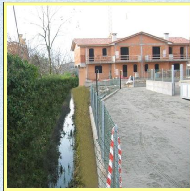
FOSSO APERTO = MANTENIMENTO DEL VOLUME D'INVASO
