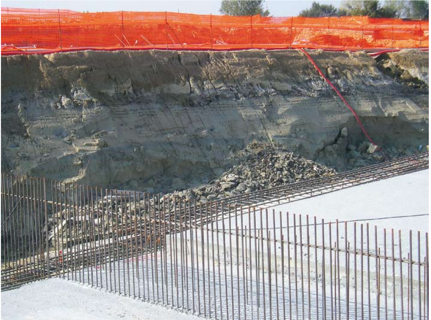
Fig. 5.13. Sezione longitudinale del paleoalveo del Lusore, sulla parete sud-ovest dello scavo, ortogonale a quella di fig. 12; lo scavo è profondo circa 7 m. Rispetto alla fig. 5.12, qui è visibile la parte più profonda dell'incisione. I sedimenti fini della piana di esondazione pleistocenica (fra i quali si nota un livello scuro arricchito di sostanza organica) sono interrotti dalla superficie erosiva ben visibile con andamento irregolare e ondulato a metà parete circa. Su di essa giacciono numerosi frammenti di legno carbonificati (fig. 14). I sovrastanti sedimenti sono costituiti da sabbie medio-grossolane ricche di matrice fine, con stratificazione incrociata concava appena visibile, passanti rapidamente a sabbie medie e fini limose e limo nella parte superiore, secondo una gradazione normale (foto Abbà T., Provincia di Venezia, 2007).
