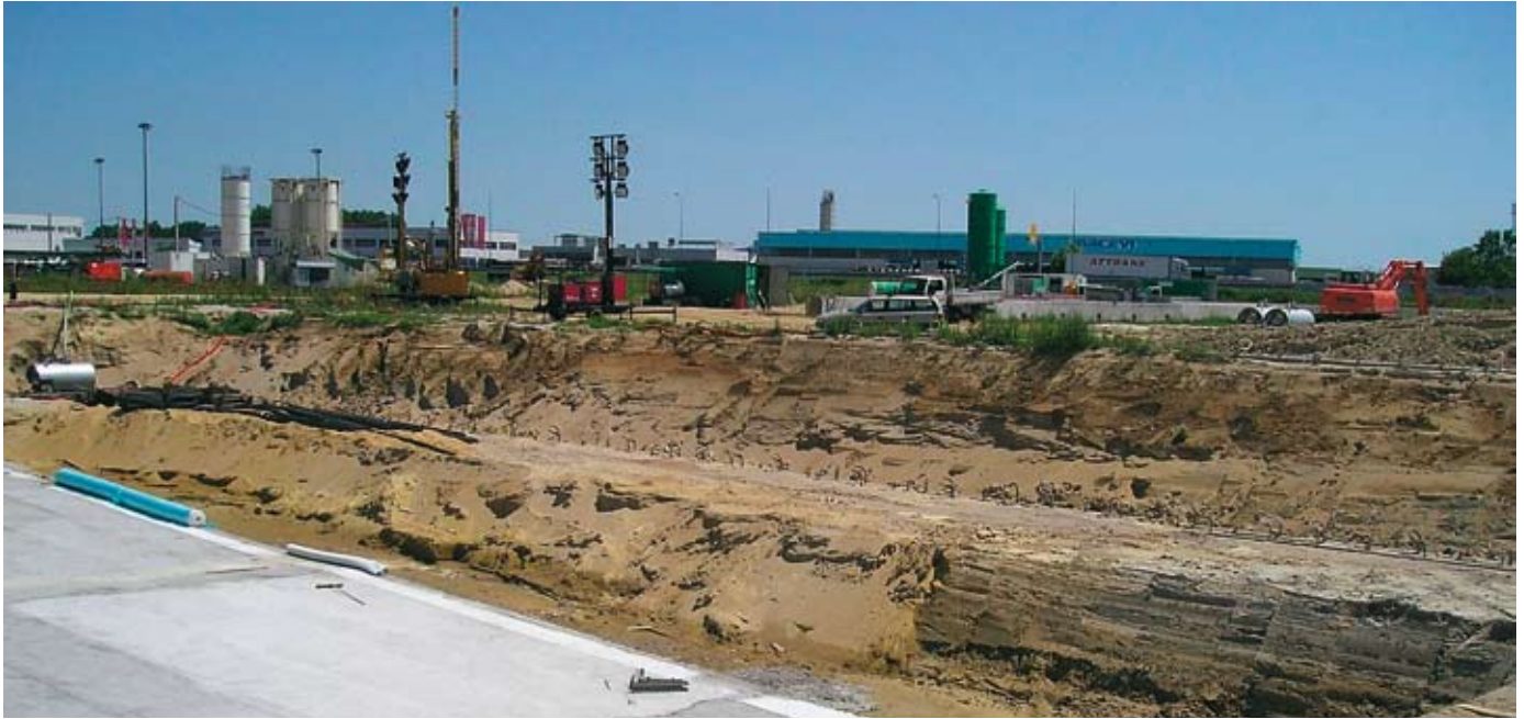
Fig. 5.2. Parete est dello scavo a luglio 2006. L'asse del paleoalveo è ad alto angolo (quasi ortogonale) rispetto alla parete. È evidente la sponda erosiva verticale che tronca i sedimenti coesivi a stratificazione orizzontale. Sulla sinistra si notano le sabbie di canale attivo con una stratificazione incrociata concava a festoni. Si veda anche la didascalia della fig. 5.3 (foto Abbà T., Provincia di Venezia, 2006).
