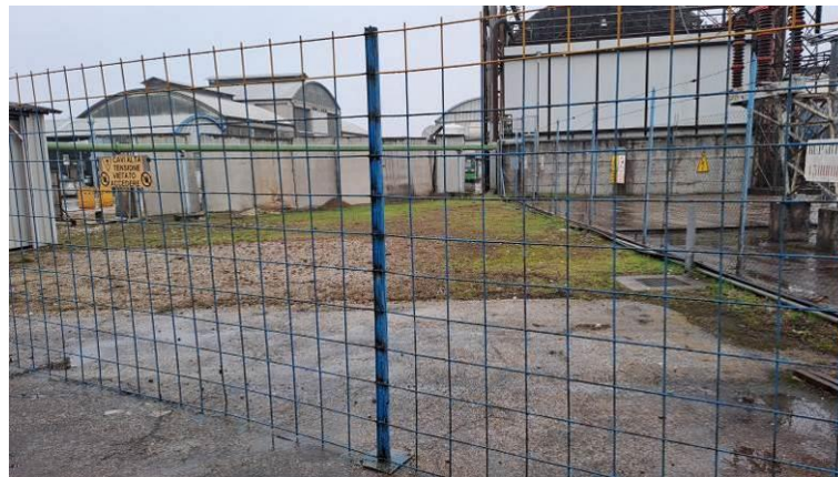
Fig. 2.3 foto area scoperta presso sottostazione elettrica
