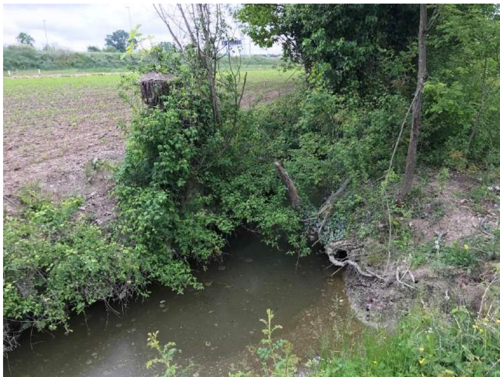
Foto 17 – Fossato di scolo a Est dell'impianto
