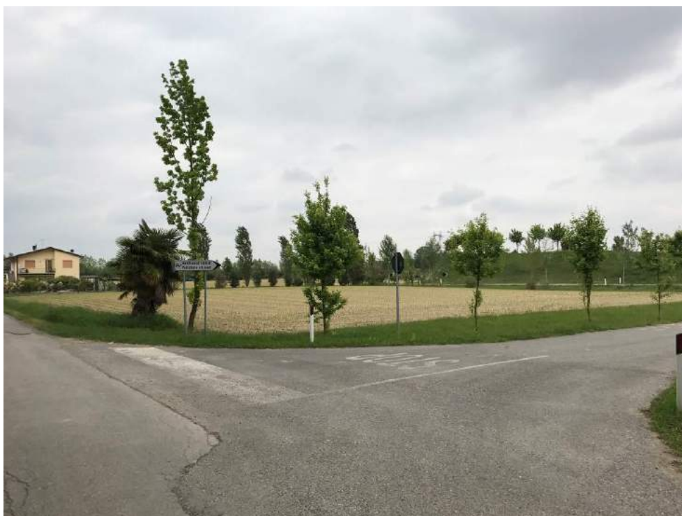
Foto 4 – Viabilità di servizio del "Passante autostradale" da Via Boschi
