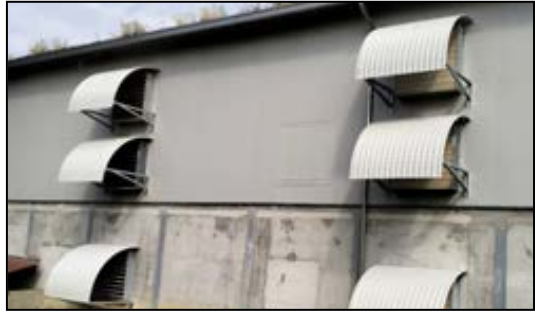
Esempio di cappottina pensile singola Dimensioni: l 140; h 140; p 50
