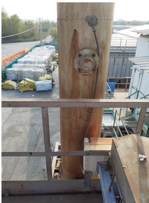
Figura 4: bocchello di campionamento del camino C28.
