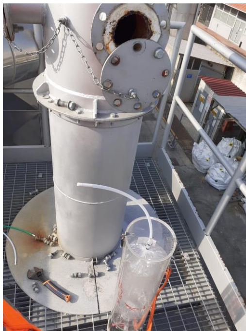
Figura 3: bocchello di campionamento del camino C38.
