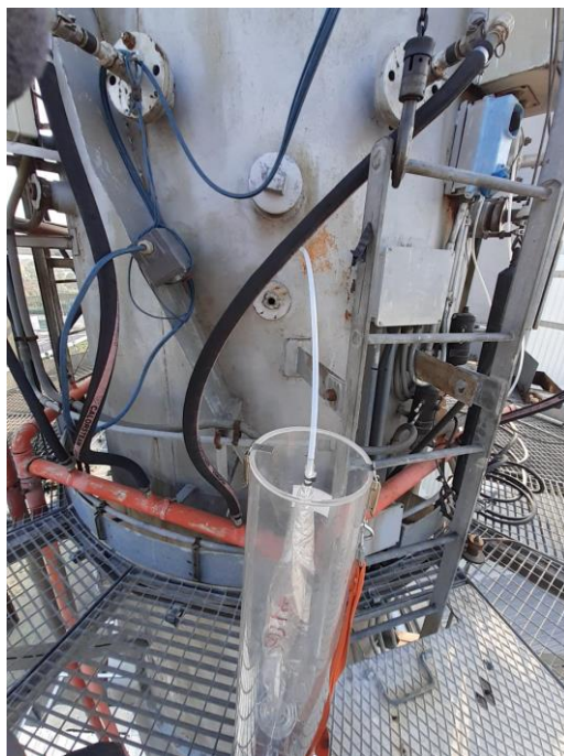
Figura 5: bocchello di campionamento del camino C3.
