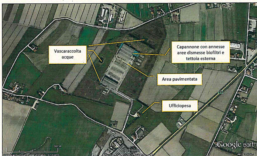
Figura Foto aerea del sito di intervento e consistenza impiantistica attuale
