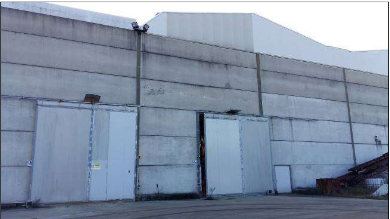
Foto 13: Lato nord dello stabilimento
