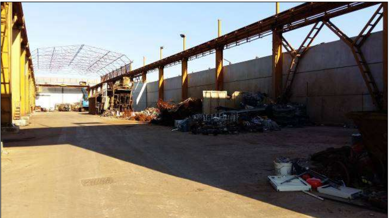
Foto 5: Parte centrale dello stabilimento
