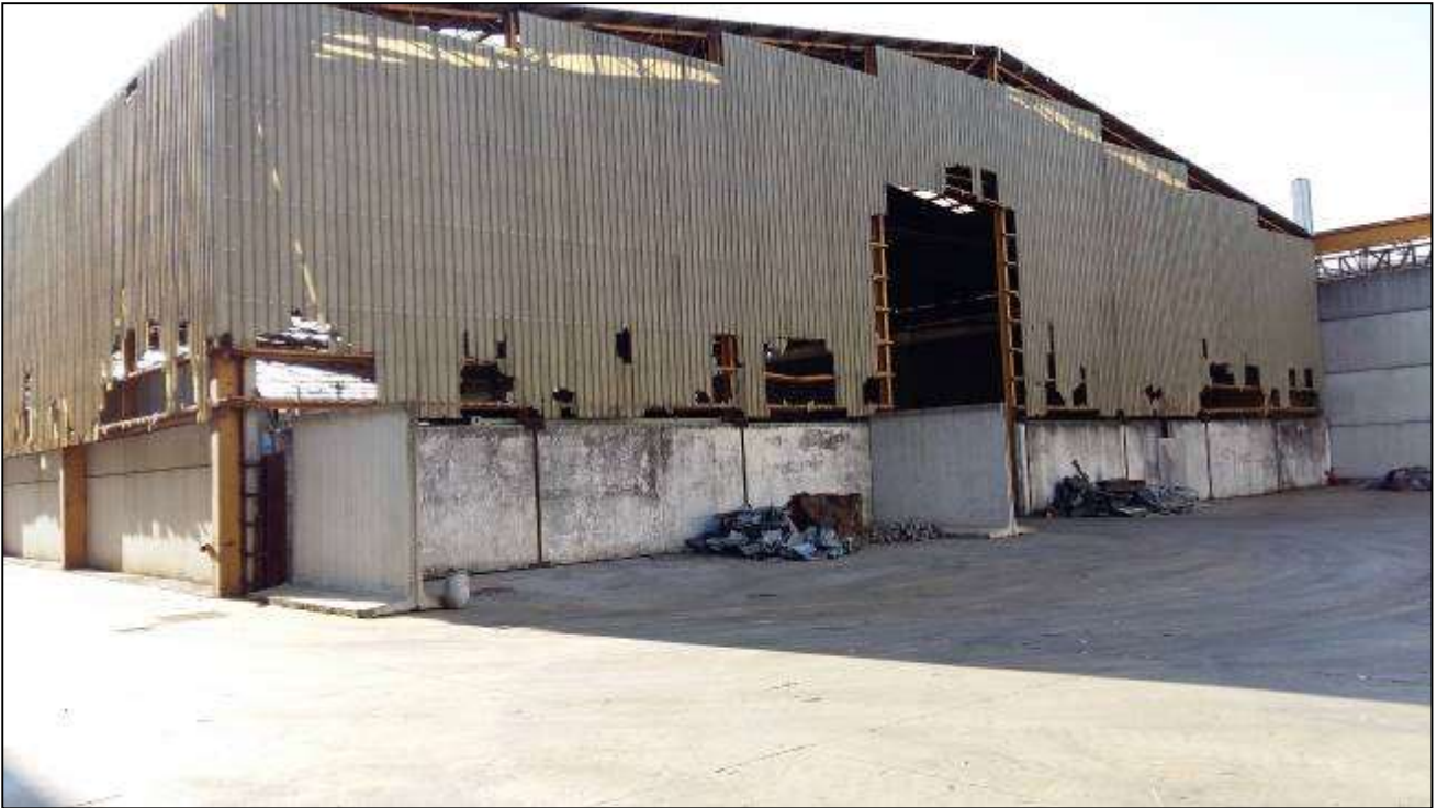
Foto 12: Area coperta nella zona ovest dello stabilimento
