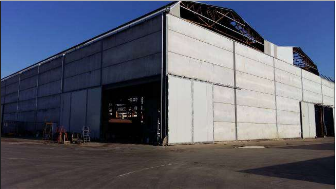
Foto 2: Angolo sud-ovest dello stabilimento
