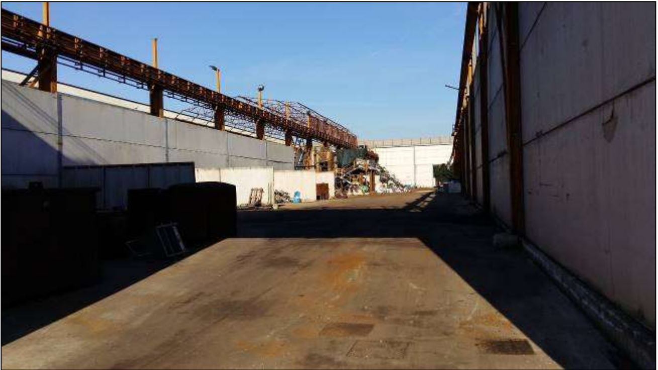
Foto 6: Parte centrale dello stabilimento
