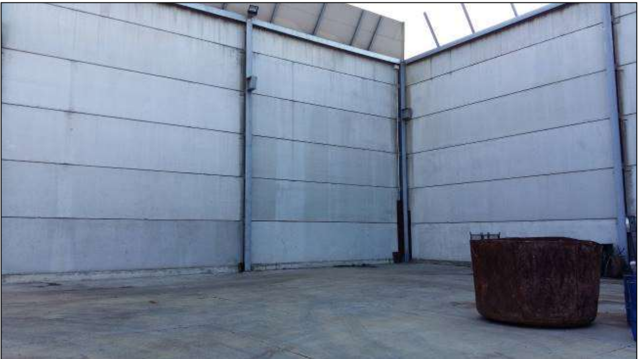
Foto 9: Particolare muro perimetrale stabilimento e zona messa in riserva rifiuti
