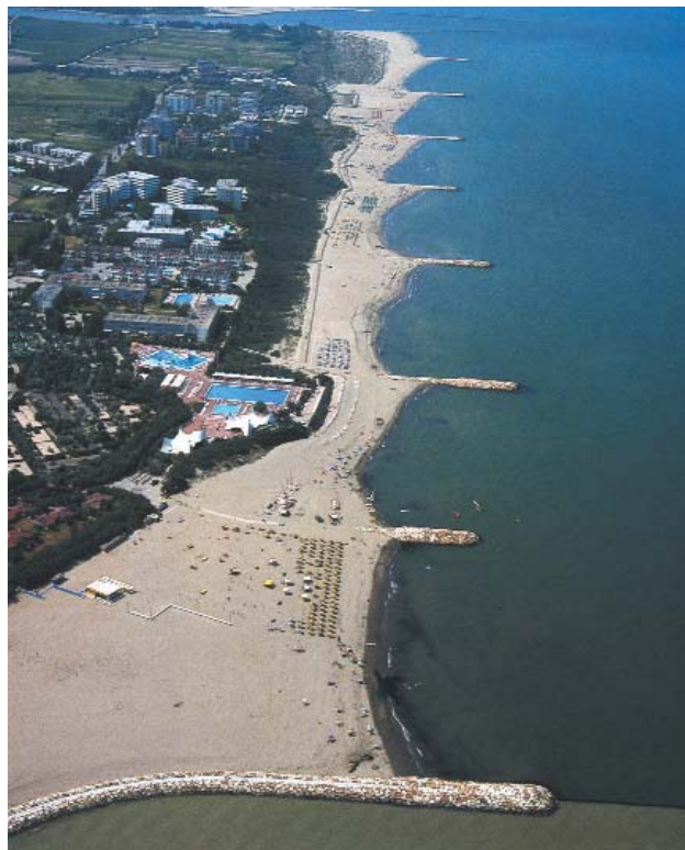
Fig. 4.128. Il nuovo assetto della spiaggia di Isola Verde, tra le foci del Brenta a nord e quella dell'Adige a sud. Le dune, in parte rinaturalizzate, sono protette da filari di fascine. Le falcature tra i pennelli evidenziano una marcata deriva settentrionale dei sedimenti (da «Quaderni Trimestrali Consorzio Venezia Nuova», n. 2, 2002b).
