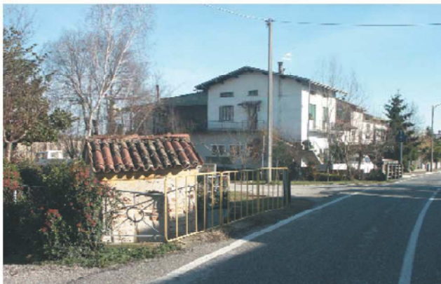
Fig. 4.6. La cappella di Santa Sabida a Fratta di Fossalta di Portogruaro. Il pavimento si trova a quasi 1 m di profondità, sepolto dalle alluvioni del Tagliamento incanalate lungo l'attuale roggia Lugugnana; verso sinistra, sulla strada, si nota il parapetto del ponte sulla roggia.
