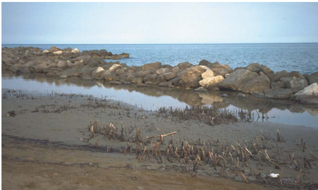
Fig. 4.109. A ovest del faro del Tagliamento l'erosione dell'arenile, in parte fronteggiata con frangiflutti, ha investito anche le dune e la loro copertura vegetale. Gli apparati radicali e i rizomi di ammophila si ritrovano direttamente a mare, testimoniando un processo di arretramento spinto, non inferiore a 80-100 m. (1997).
