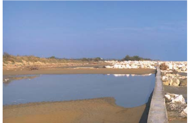
Fig. 4.120. Particolare del ristagno d'acqua entro le celle di fig. 4.119, dopo una mareggiata. A sinistra si nota il cordone di avandune, privo di continuità morfologica con la spiaggia. In più occasioni infatti le onde riescono a scavalcare la palancola, allagando la spiaggia che mantiene l'umidità, inibendo il trasporto di sabbie che alimentano le dune retrostanti (1997).
