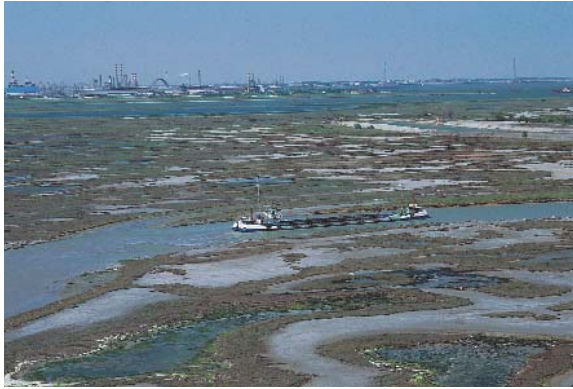
Fig. 3.28. Particolare della cassa di colmata B. Le casse di colmata sono aree del bacino lagunare localizzate nei pressi di Porto Marghera (visibile sullo sfondo), sottoposte negli anni sessanta a vasti interramenti per una ulteriore espansione della zona industriale.
