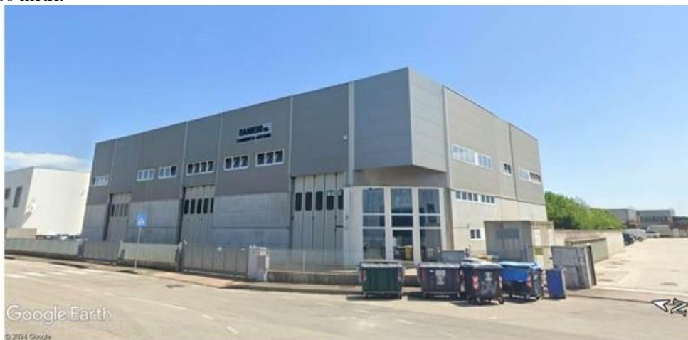
Figura 3 Visione da via dell'Industria del lato Sud-Ovest del capannone della ditta Ranieri srl
