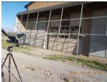
Foto con 4 ventilatori "aperti" (in funzione)
