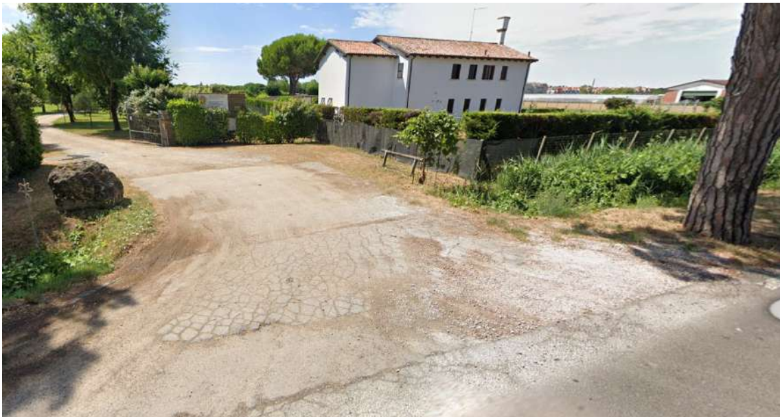
Immagine n. 5 – Veduta dell'accesso principale all'impianto
