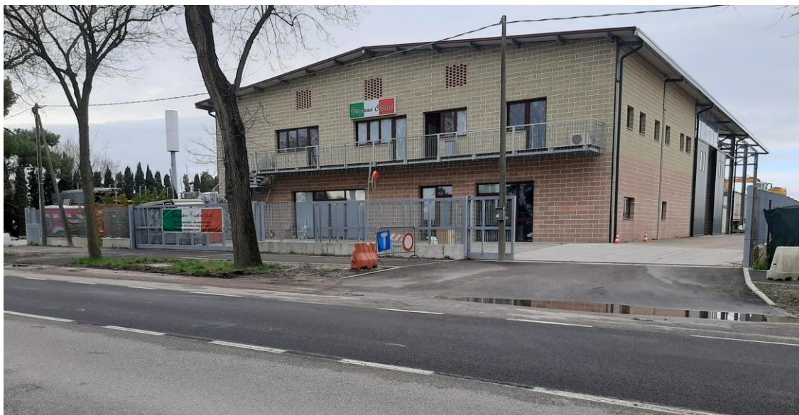
Figura 6: – Veduta dell'accesso principale all'impianto
