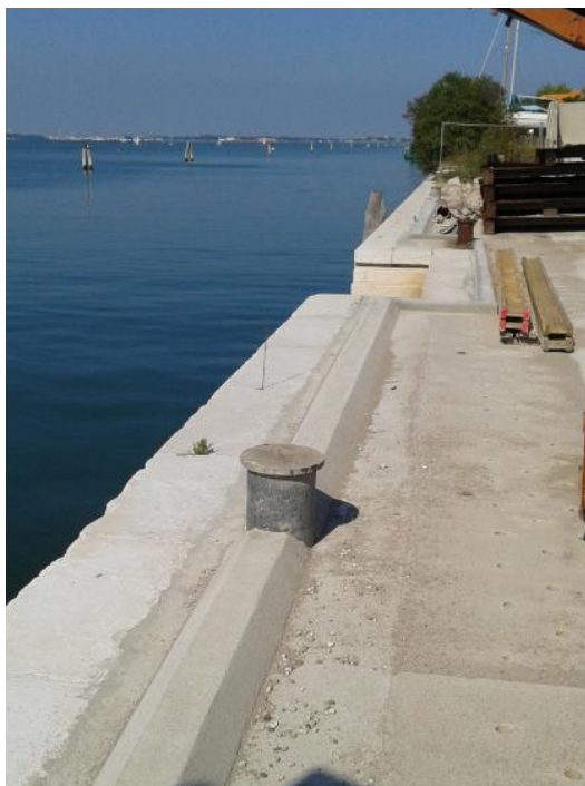
Figura 5: – Banchina di ormeggio
