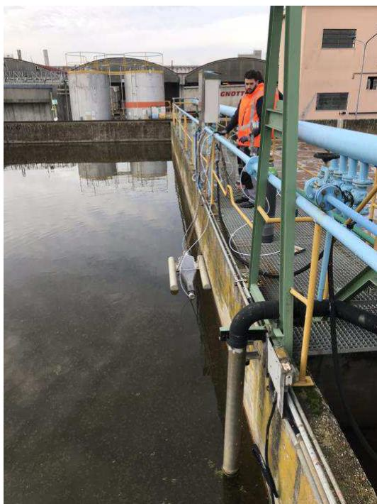
**Figura 5:** Campionamento sulla vasca di sedimentazione secondaria
