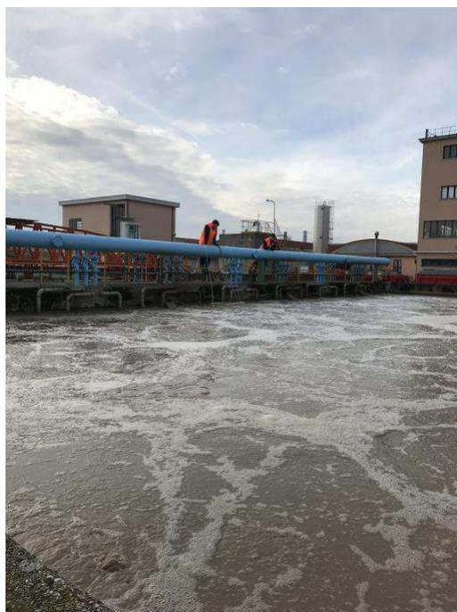
**Figura 7:** campionamento sulla vasca di ossidazione primaria
