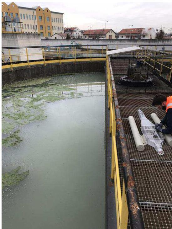
**Figura 2:** Vasca di ispessimento fanghi
