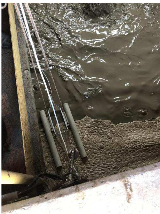
**Figura 3:** Punto di prelievo vasca di mineralizzazione
