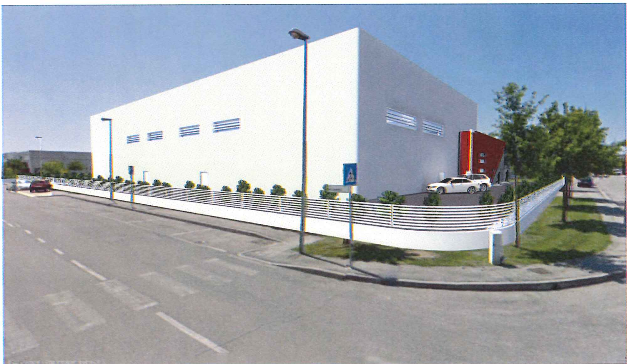
Immagine virtuale significativa ad opera completata -Vista 2 (angolo Via dell'Industria con Via del Lavoro)-
