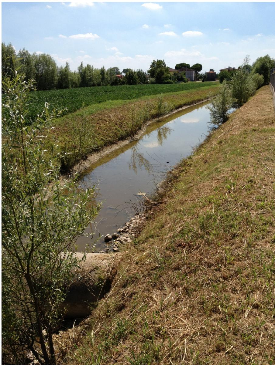
*Figura 2.15 – Il fosso di invaso realizzato ad est della lottizzazione (in base allo studio idraulico del 2002)*
