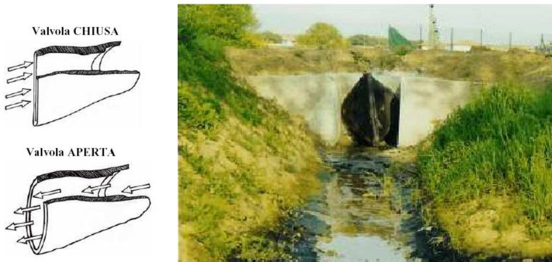
Figura 7.2 – Applicazione di una valvola a membrana ad un canale
