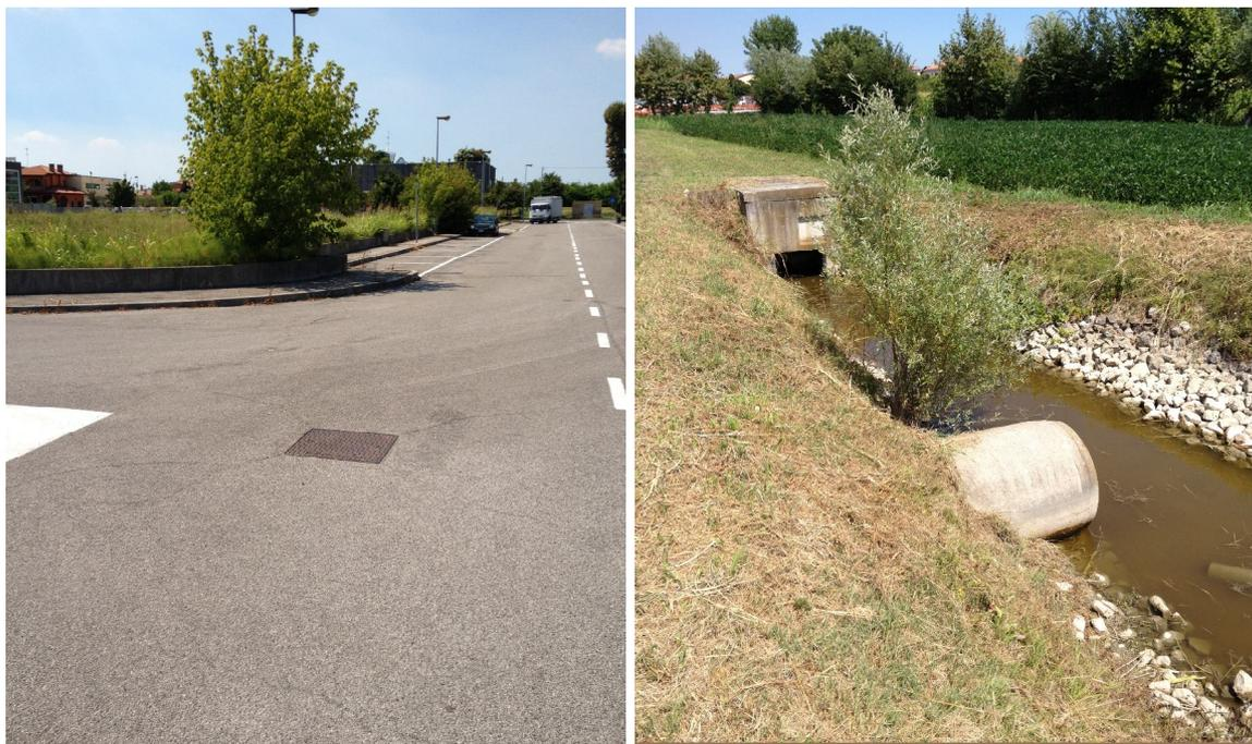
*Figura 4.1 – il pozzetto di recapito in via del lavoro e la condotta uscente nel fosso d’invaso*
