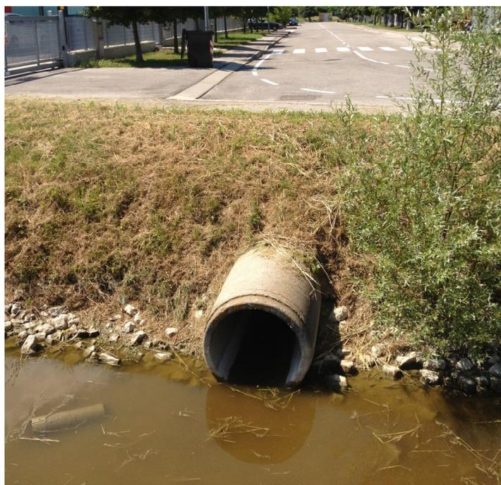
*Foto 02 – la condotta di diametro 800 mm di via del lavoro all'uscita nel bacino di invaso*
