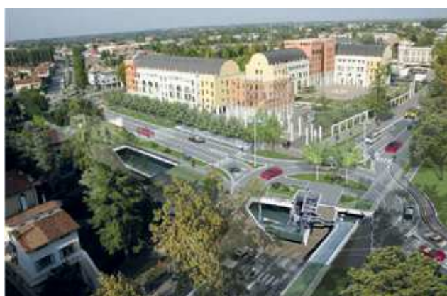
Fig. 4.25 - Spaccato del nuovo impianto idrovoro Ronchi a Portogruaro al centro della rotonda (2008).
