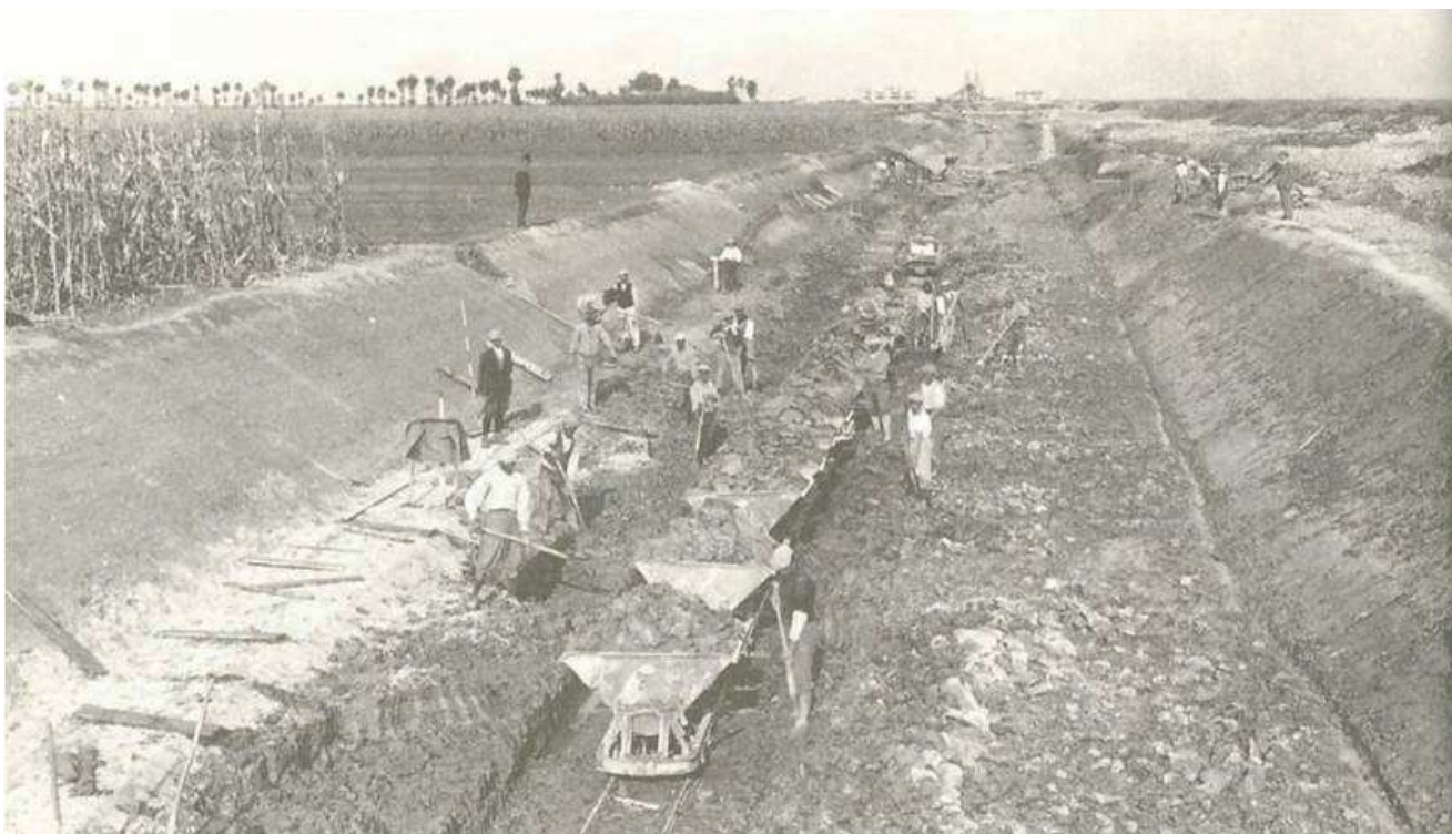
Fig. 4.17 - Lavori di scavo di un canale di bonifica: gli scarriolanti.
