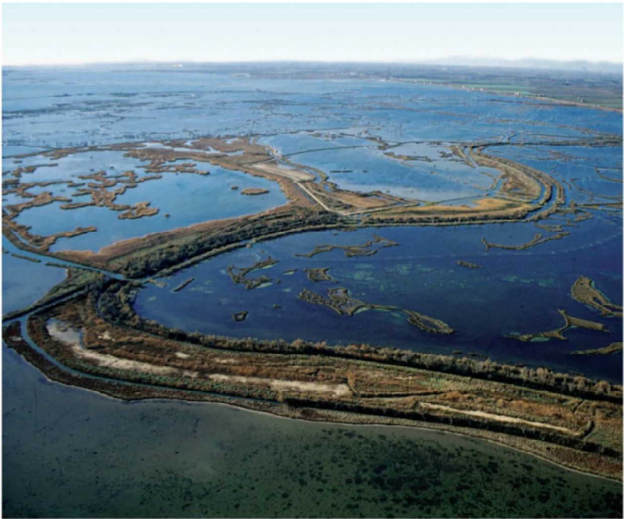
L'immagine mostra il dosso sul quale sono stati realizzati ripetuti ed importanti interventi di natura idraulica che consentono lo scambio idrico tra le valli e la laguna (foto Bondesan A. - Provincia di Venezia, 16/12/2003).
