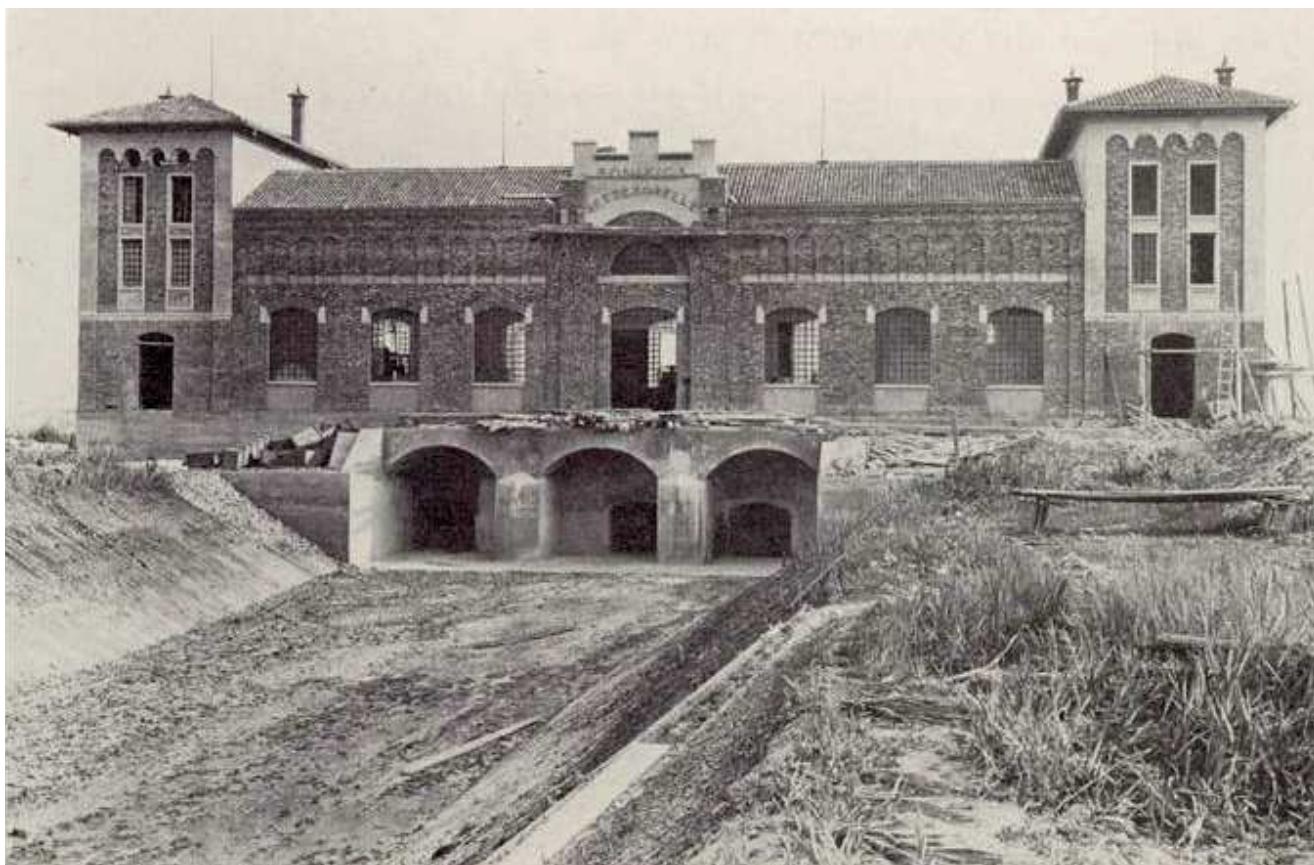
Fig. 4.20 - L'impianto idrovoro Sette Sorelle a S. Stino di Livenza a lavori ultimati (1928).
