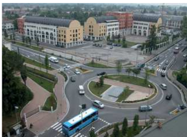
Fig. 4.26 - Il nuovo impianto idrovoro Ronchi a Portogruaro e la riconfigurazione viaria (2008).
