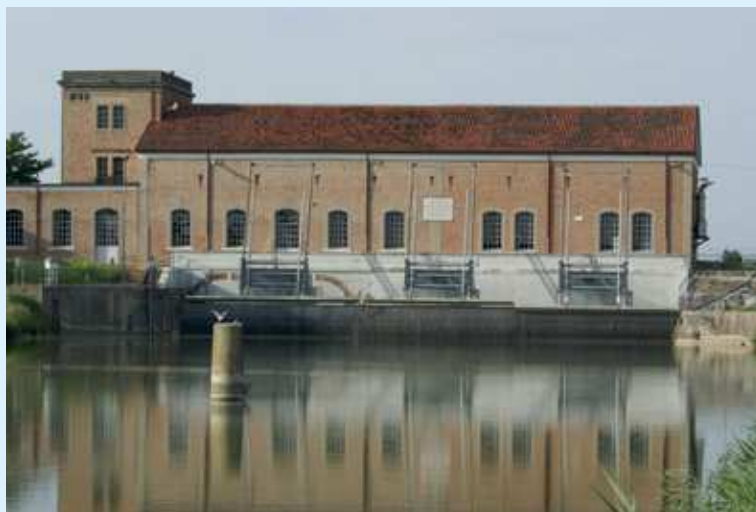
Fig. 4.30 - L'impianto idrovoro di Cittanova (San Donà di Piave), alla confluenza fra i canali Brian e Ramo.
