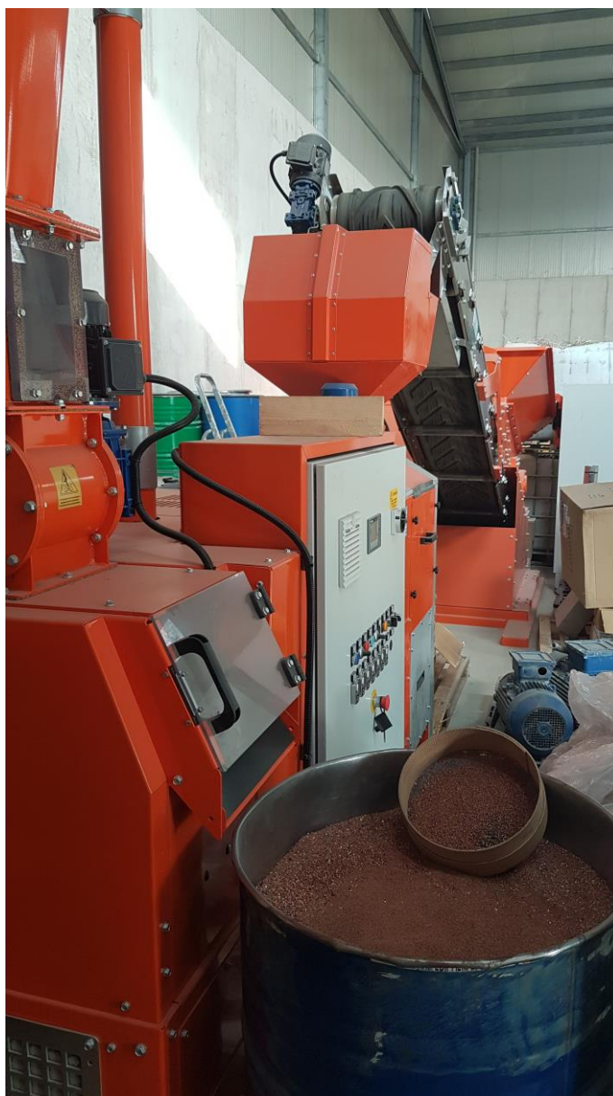
Figura 12: Foto dell'impianto di recupero del rame dai cavi
