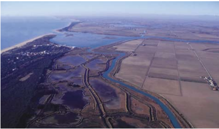
La Vallesina di Bibione con il suo sistema di argini e specchi d'acqua in parte occupati da barene. Si noti la contrapposizione tra l'ambiente lagunare e quello geometricamente ordinato della bonifica agricola. Al centro l'area di Porto Baseleghe e oltre il litorale di Valle Vecchia (foto Fontana A. - Provincia di Venezia, 14/12/2004).
