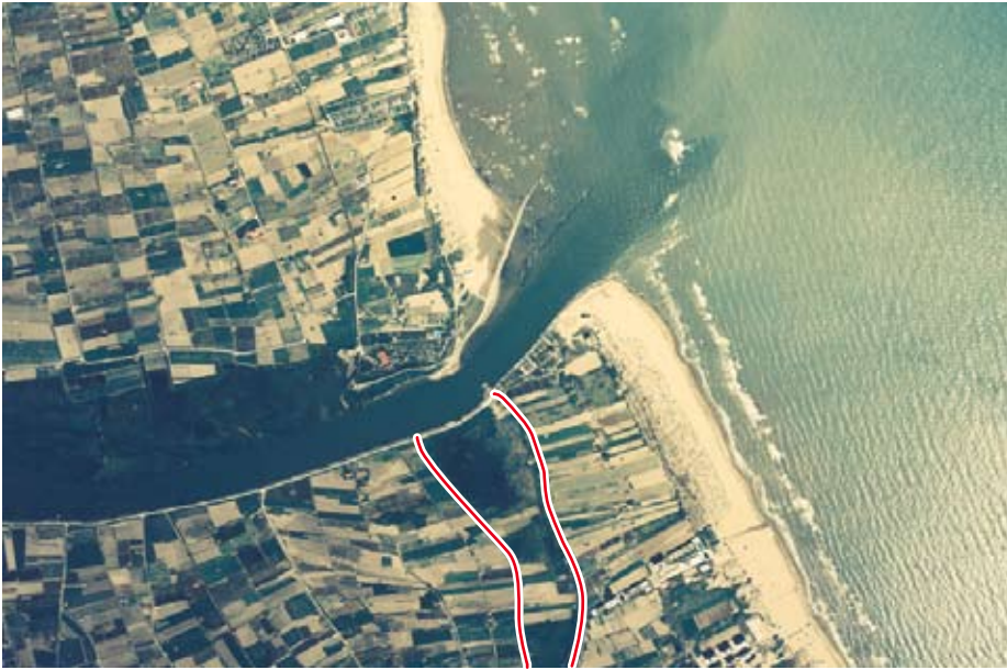
L'attuale foce del Brenta rivela in destra idrografica la presenza di una fascia umida (visibile perché scarsamente coltivata e con presenza di stagni) all'incirca parallela alla costa che segnala l'esistenza di un tratto del paleoalveo corrispondente all'antico percorso del ramo di foce (Volo REVEN 87, 1987, str. 17B, n. 5139, CGR).
