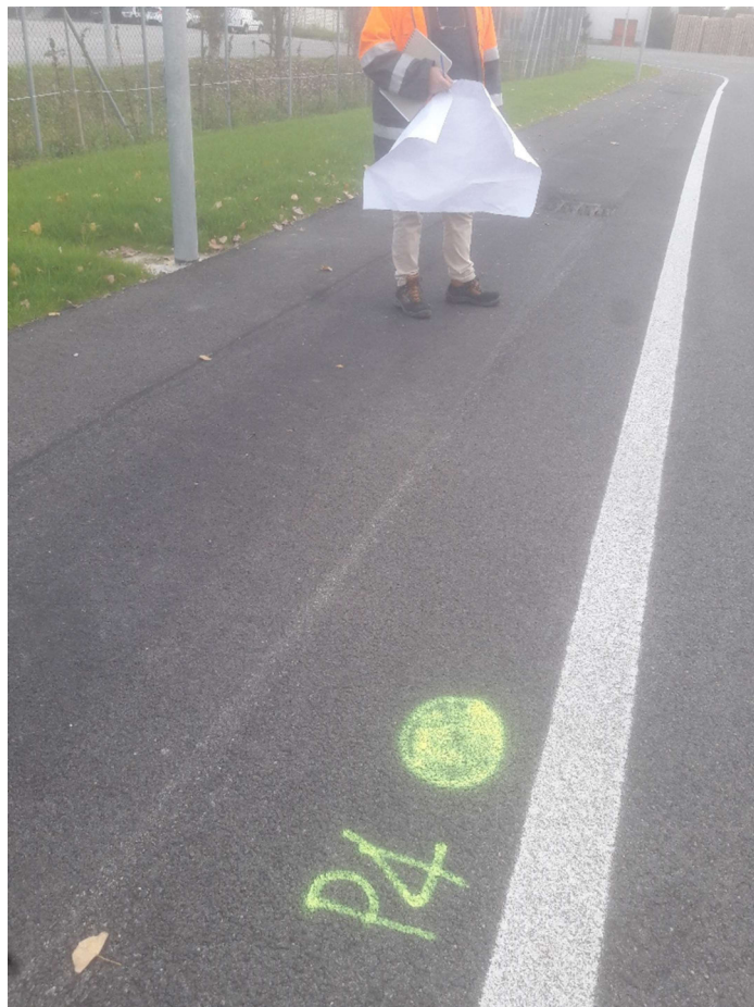
Esecuzione del piezometro P4 definitivo (monte) – ad est magazzino G e formazione di dreno in ghiaino calibrato
