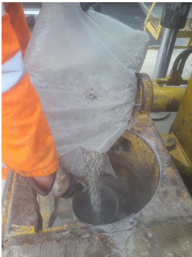
Esecuzione del piezometro P4 definitivo (monte) – ad est magazzino G e formazione di dreno in ghiaino calibrato
