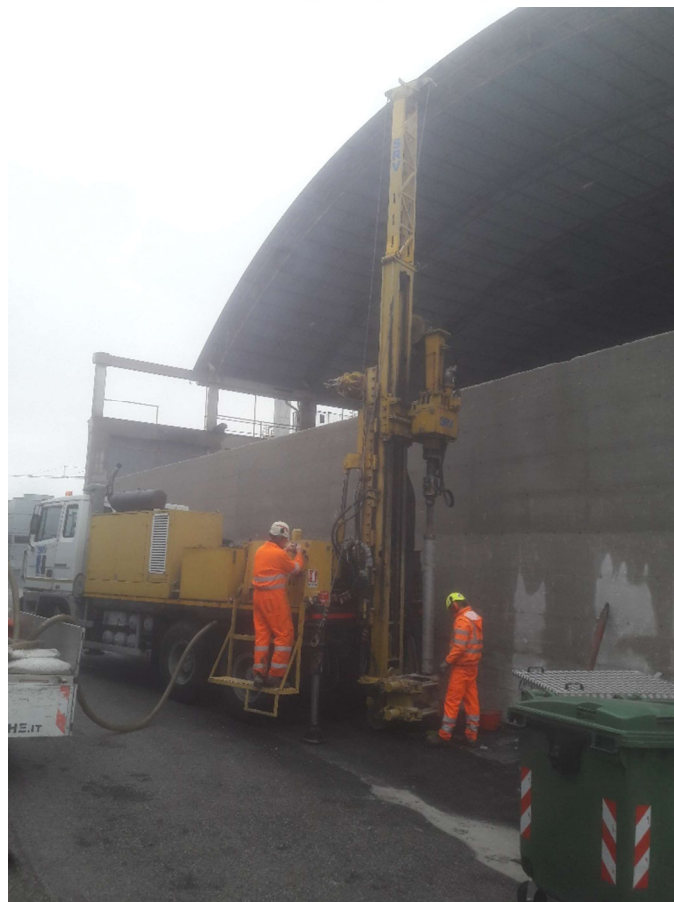
Esecuzione del piezometro P2 definitivo (valle) presso il vecchio deposito sabbia
