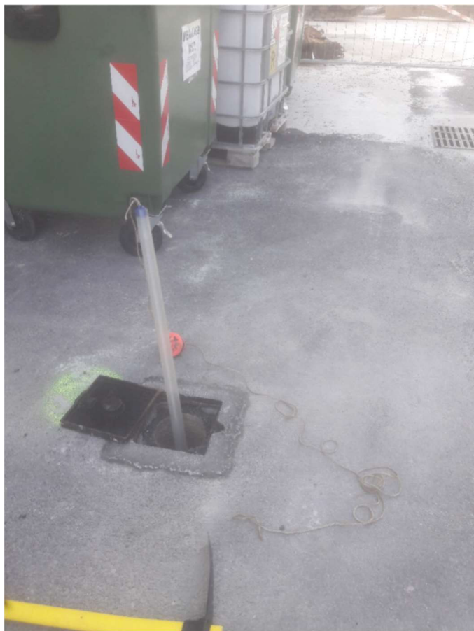
Esecuzione del piezometro P2 definitivo (valle) presso il vecchio deposito sabbia
