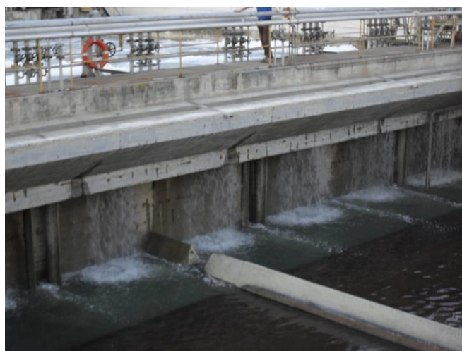
Riempimento sedimentatore primo stadio
