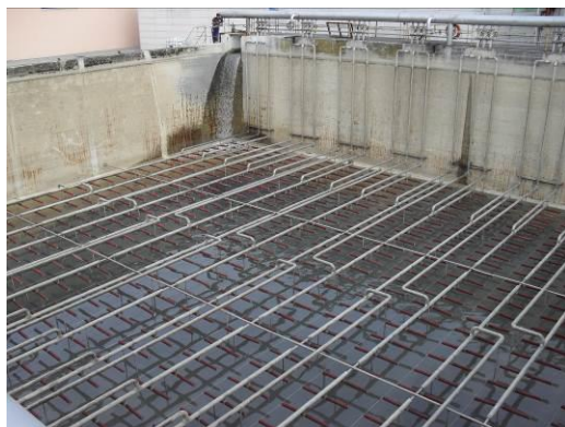
Sistema di diffusione dell'aria – candele ceramiche
