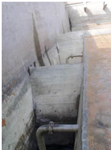
Tramogge di raccolta fango sedimentato 1° stadio
