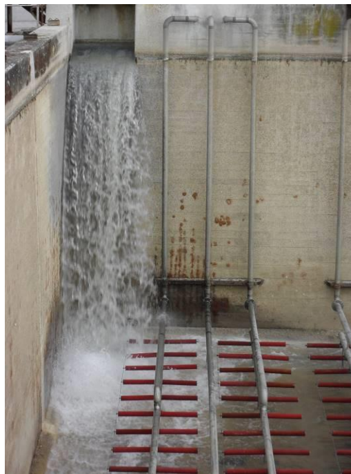
Riempimento dell'aeratore primo stadio
