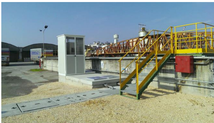
Sistema di recupero acqua non conforme da uscita 2° stadio
