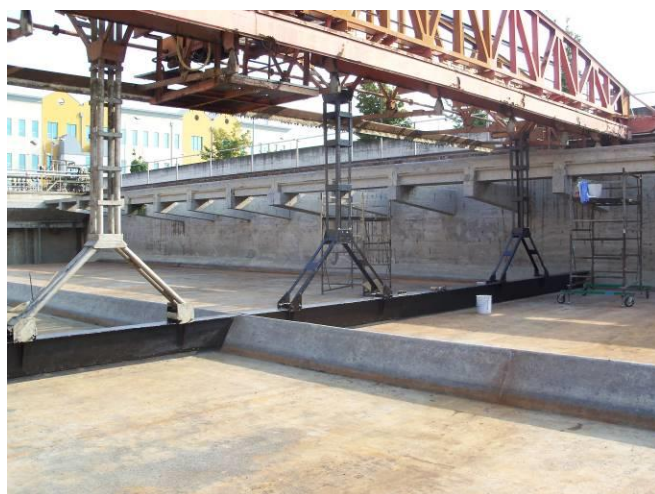
Sedimentatore primo stadio svuotato e pulito
