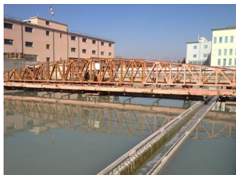
Carroponte e canaletta d'uscita primo sedimentatore
