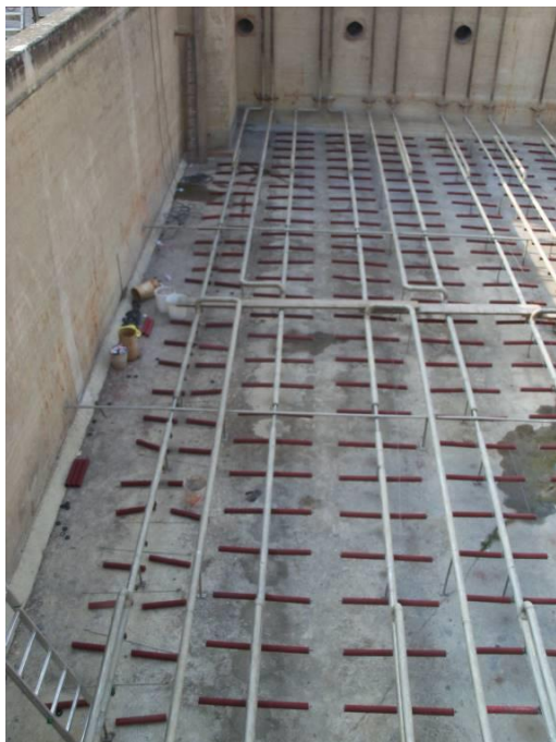
Aeratore primo stadio Montaggio nuovi diffusori dopo pulizia di tutte le connessioni
