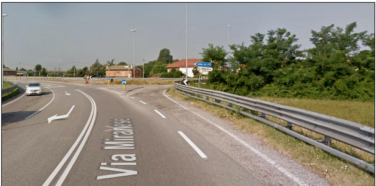
Figura 5.5. Svincolo di via Miranese (fonte Google Maps)
