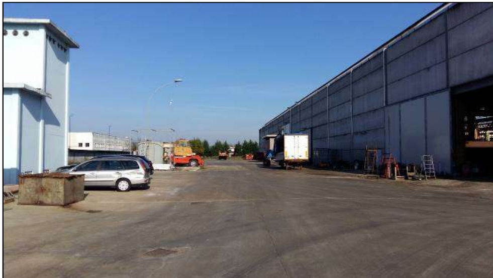
Foto 3: Lato ovest dello stabilimento
