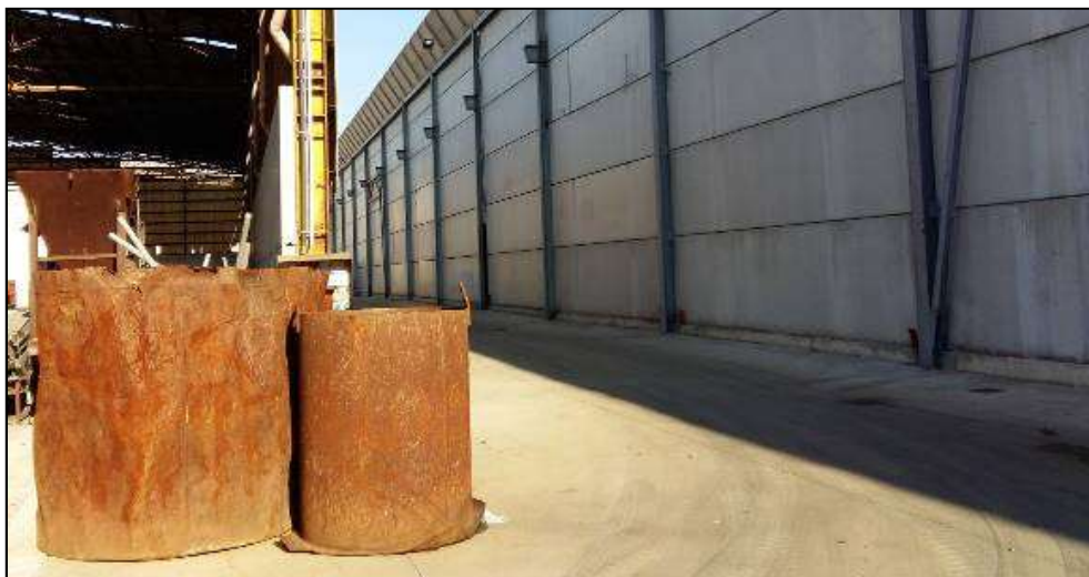
Foto 10: Particolare muro perimetrale stabilimento e zona deposito materie prime secondarie
