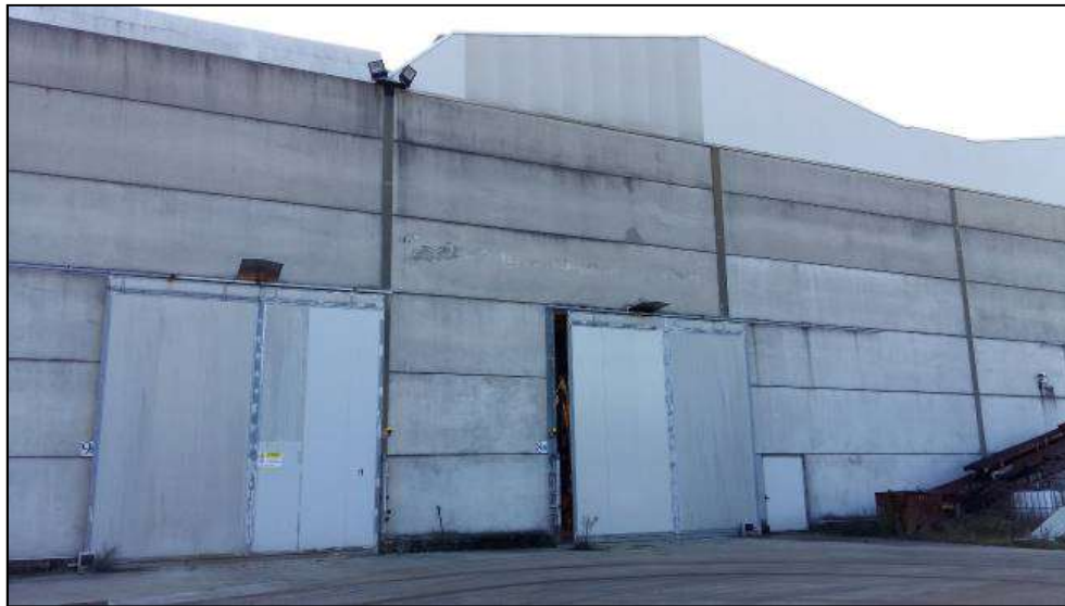
Foto 13: Lato nord dello stabilimento
