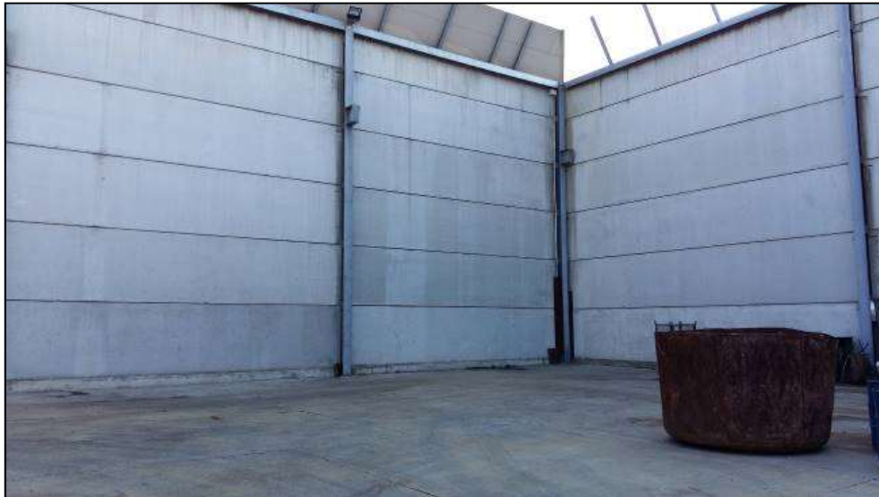
Foto 9: Particolare muro perimetrale stabilimento e zona messa in riserva rifiuti
