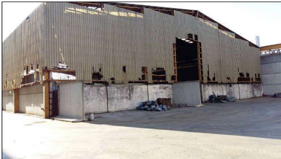
Foto 12: Area coperta nella zona ovest dello stabilimento
