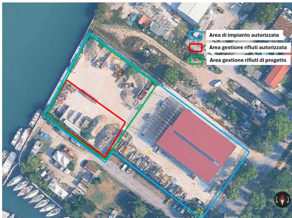
Figura 1: illustrazione area di impianto e ampliamento
