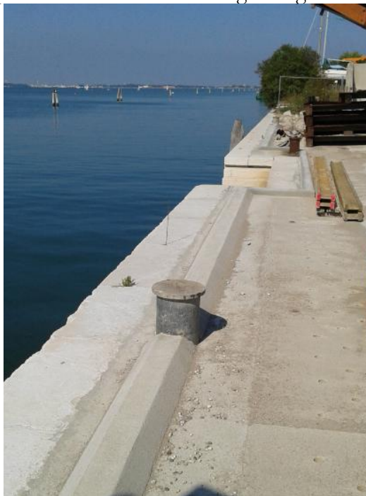
Figura 5: Banchina di ormeggio
