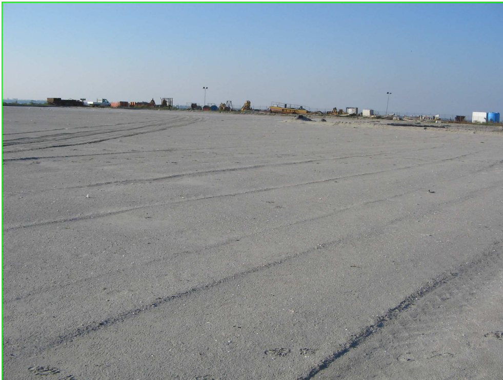
Figura 39 – L'area vista in fase di predisposizione (foto anno 2007).
