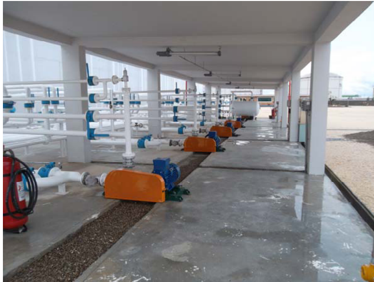
Esempio di locale sala pompe a ventilazione naturale
