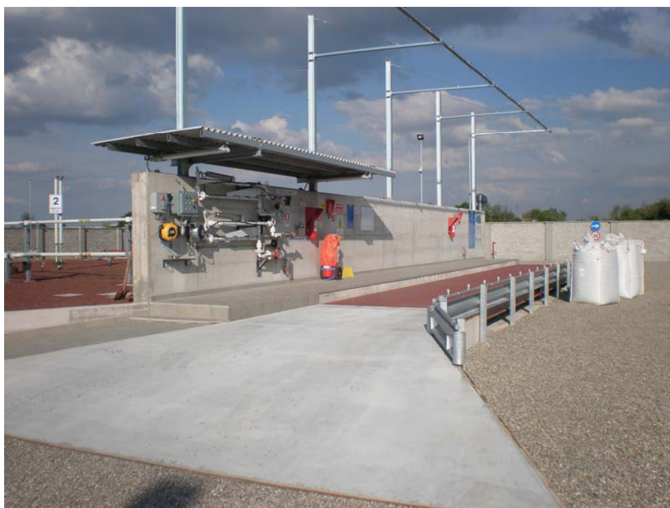
Esempio di punto di travaso con stadera sopraelevata
