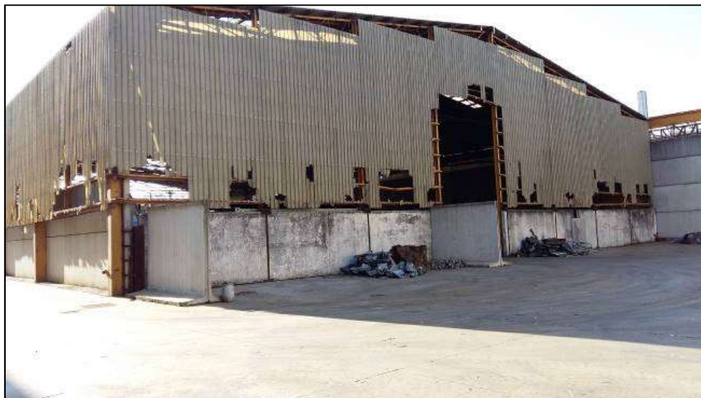
Foto 12: Area coperta nella zona ovest dello stabilimento
