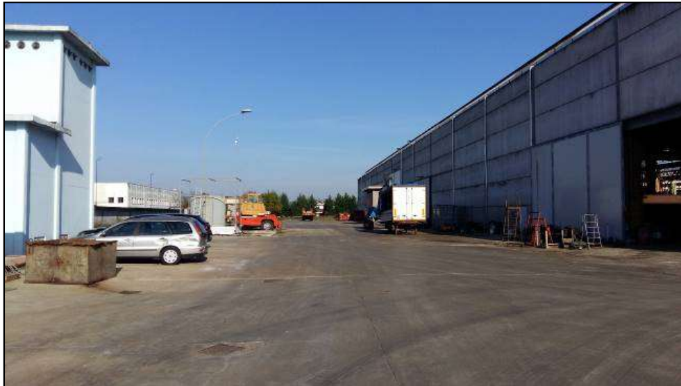
Foto 3: Lato ovest dello stabilimento
