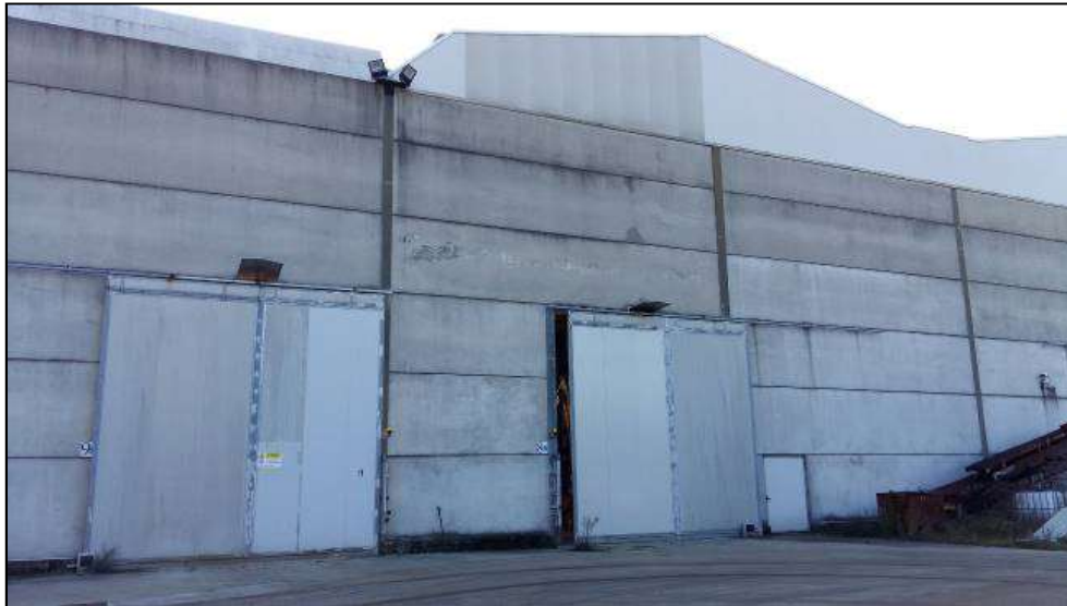
Foto 13: Lato nord dello stabilimento
