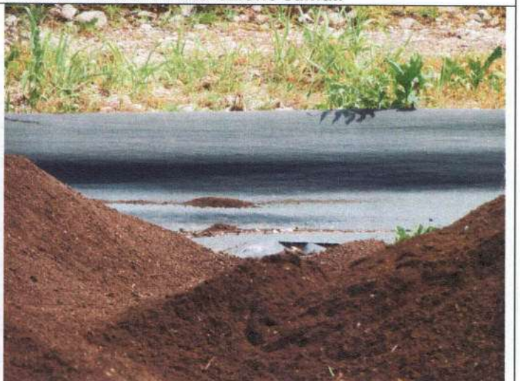
Foto 22 – particolare del telo in HDPE
