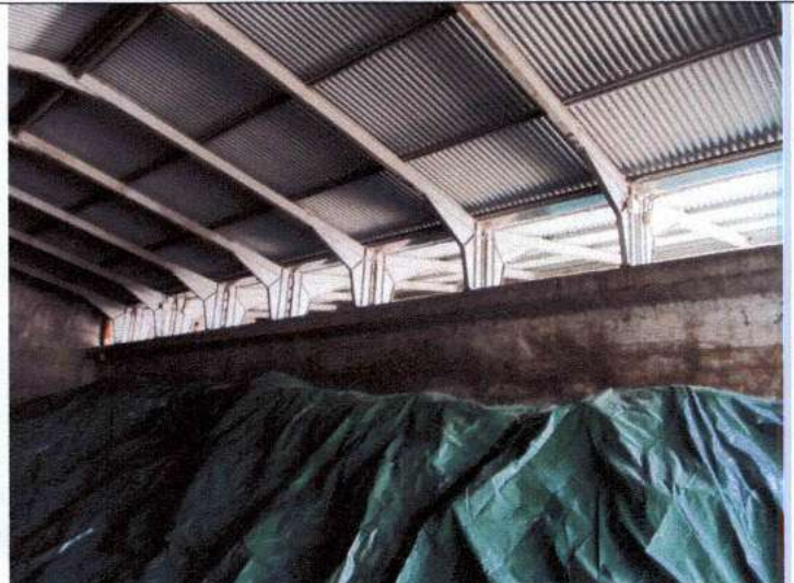
Foto 10 – particolate copertura vasca in calcestruzzo
